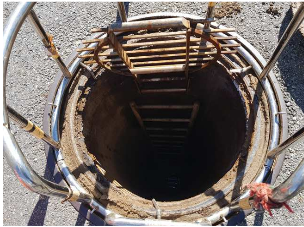
내용 안전손잡이, 사다리 상태양호
